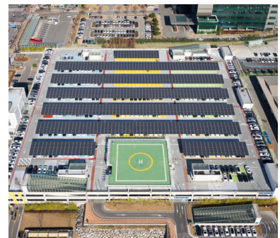
— 수원사업장 주차타워 옥상에 설치된 태양광 발전 설비
