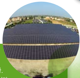
이탈리아에 설치된 태양광모듈
